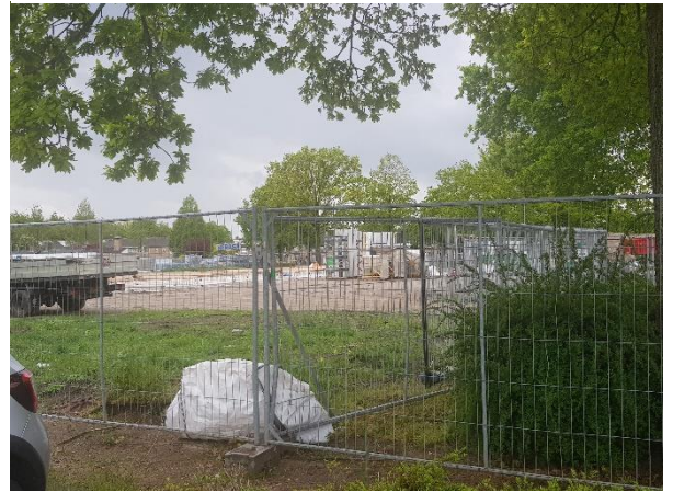
Afbeelding 1.1: Laatste fase nieuwbouwproject Bloemenoordflats.
