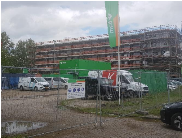
Afbeelding 1.2: Nieuwbouwproject Bloemenoordflats in Waalwijk in aanbouw.
